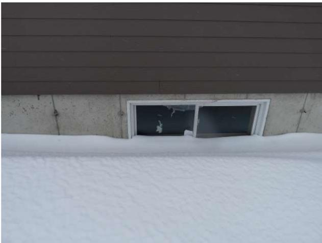
Les fenêtres du sous-sol sont un endroit stratégique, car l'eau de pluie peut y entrer facilement et abondamment. Pour éviter que l'eau ne s'infilte par les fenêtres du sous-sol, on s'assure d'avoir un dégagement d'au moins 20 cm (8 po) entre le terrain fini à l'extérieur et le dessous de la fenêtre du sous-sol.
